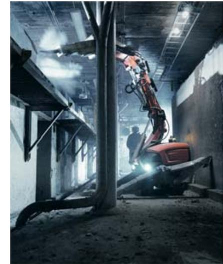
Der DXR 310 ist auf engstem Raum leicht zu manövrieren und die Konstruktion ist moderner und funktioneller als andere Maschinen auf dem Markt. Die lange Reichweite des Arms, der stufenlose Slow-Motion-Betrieb und verschiedene Werkzeuge gewährleisten maximale Benutzerfreundlichkeit und Präzision. Die kräftige Schutzhaube aus Metall ist zeitgemäß gestaltet und die Scheinwerfer sowie Hebeösen sind in der Maschine integriert, die dadurch extrem robust, strapazierfähig und stabil ist.
